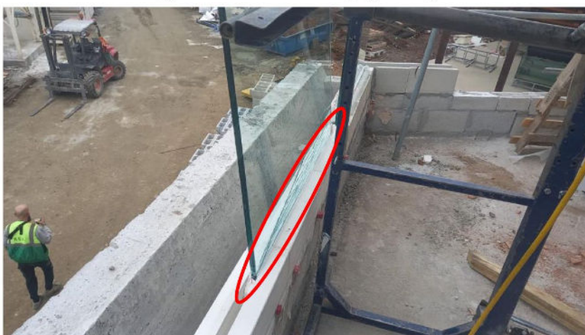
Fotografía n°3: Rotura cristal.
